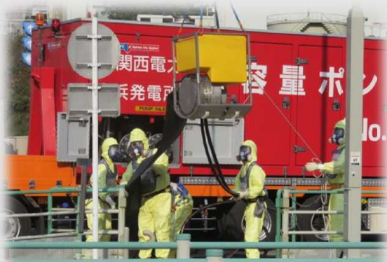
＜大容量ポンプ接続訓練＞
