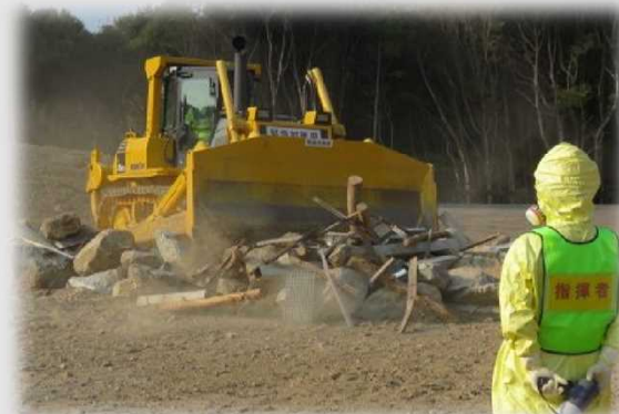
＜がれき撤去訓練＞
