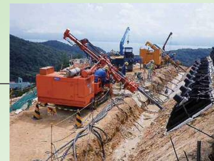
▲耐震裕度向上工事 (写真: 発電所斜面の大規模な地滑り防止工事) 2006年9月~
