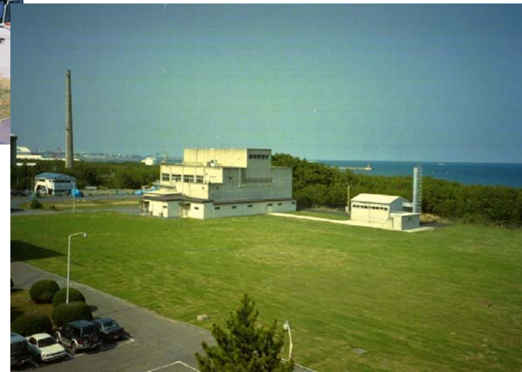
解体完了後(1996年3月)
