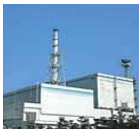
東海第二発電所
