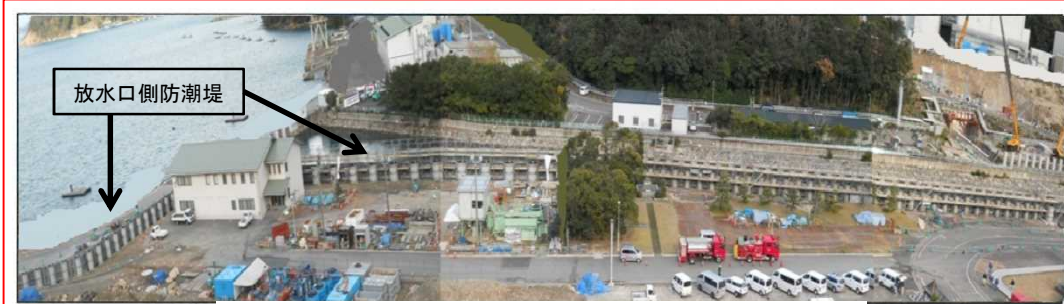
放水口側防潮堤
