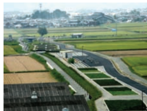
山寺川市街地排水浄化施設「伯母川ピオ・パーク」
