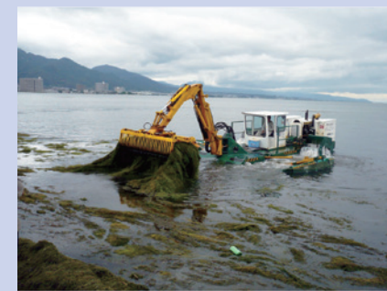
写真T-4 漂着した沈水植物の除去作業
