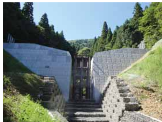
藤巻谷砂防えん堤（長浜市余呉町）
