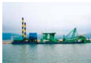
底質改善対策 （高濃度薄層浚渫）
