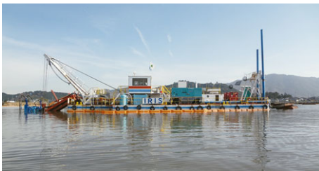
底質改善対策（高濃度薄層浚渫）
