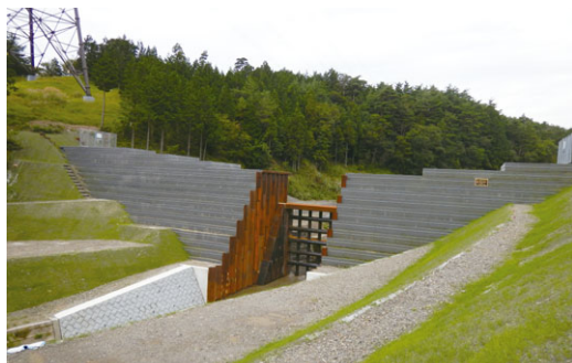
平子川えん堤 (日野町)
