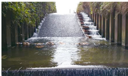
落差工に設置した魚道
