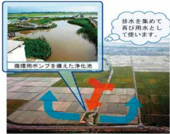
循環かんがい施設(水質保全対策事業 木浜地区)
