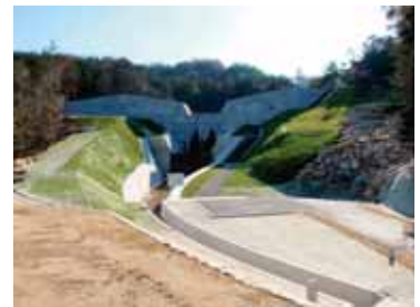
大山川支流えん堤 (野洲市南堤)
