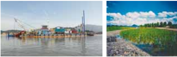
底質改善対策 (高濃度薄層浚渫)
