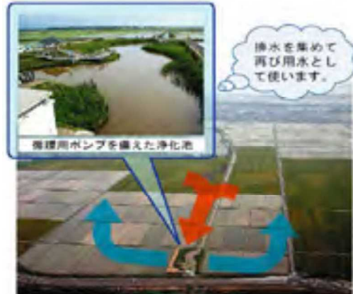
循環かんがい施設（水質保全対策事業 木浜地区）
