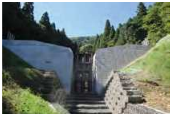
藤巻谷砂防えん堤（長浜市余呉町）
