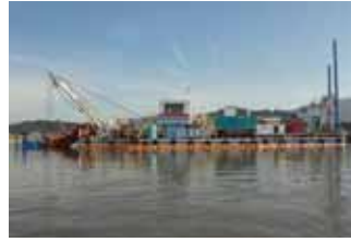
底質改善対策 (高濃度薄層浚渫)
