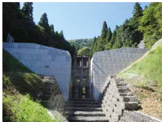
藤巻谷砂防えん堤（長浜市余呉町）
