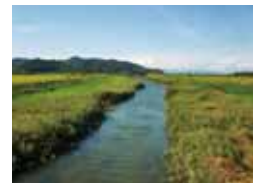
長命寺広域河川改修事業(蛇砂川：近江八幡市)
