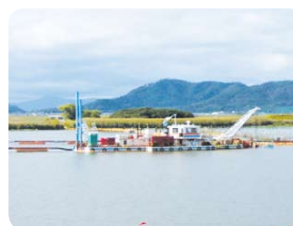
底質改善対策 （高濃度薄層浚渫）
