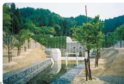
南谷砂防えん堤(米原市)
