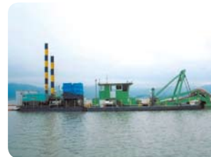
底質改善対策 (高濃度薄層浚渫)
