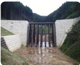
大杉川通常砂防事業(多賀町大杉) 透過型砂防えん堤
