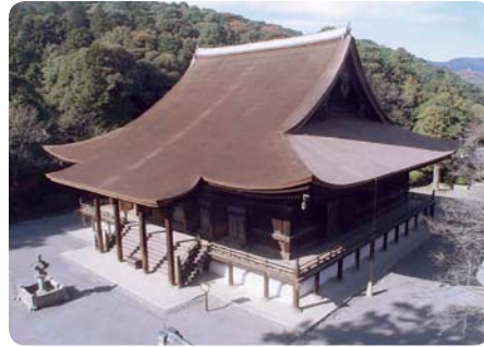
国宝・園城寺金堂 （平成20年度屋根（檜皮葺）葺替修理完了 （大津市園城寺町）
