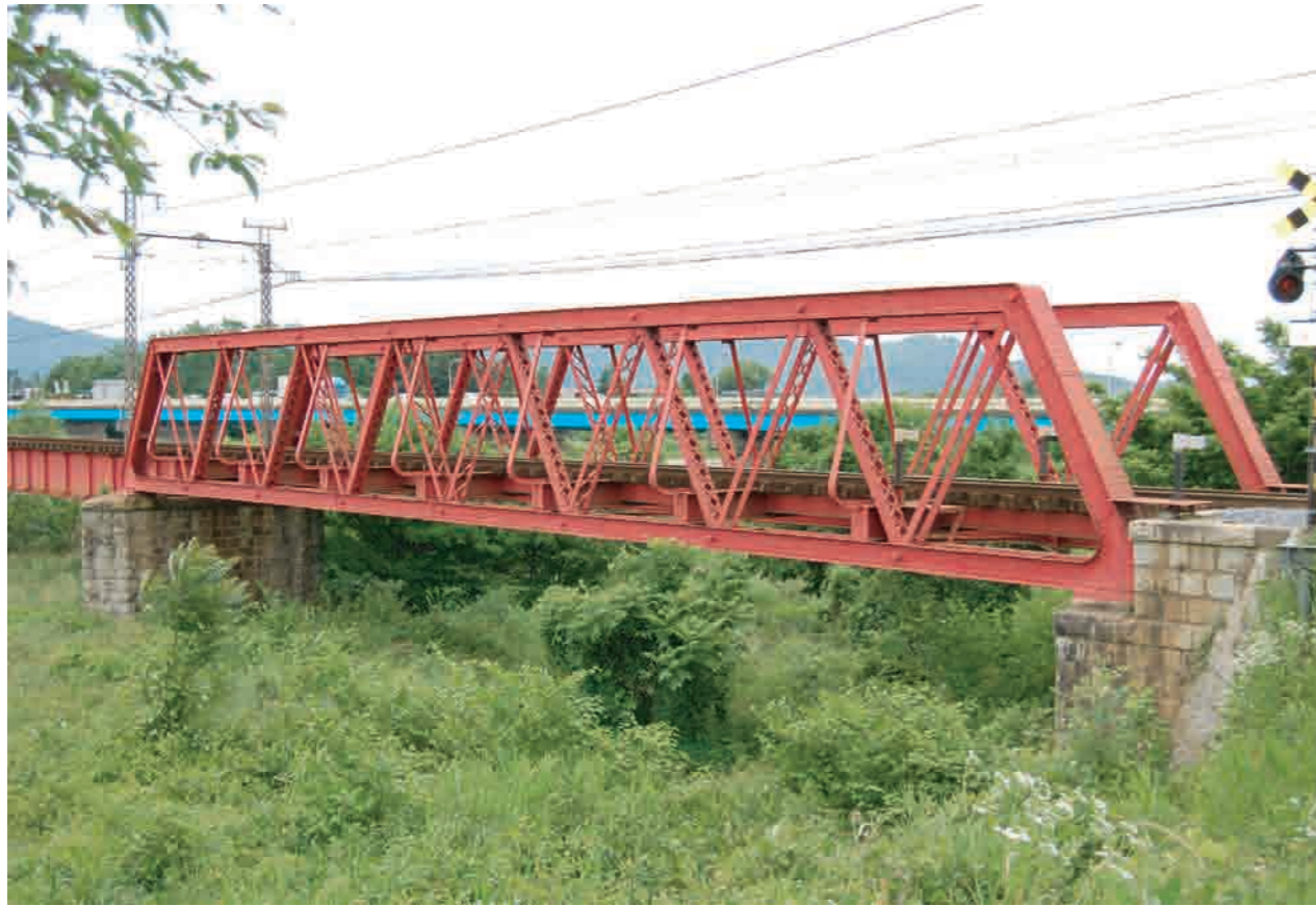
近江鉄道愛知川橋梁ポニーワーレントラス
