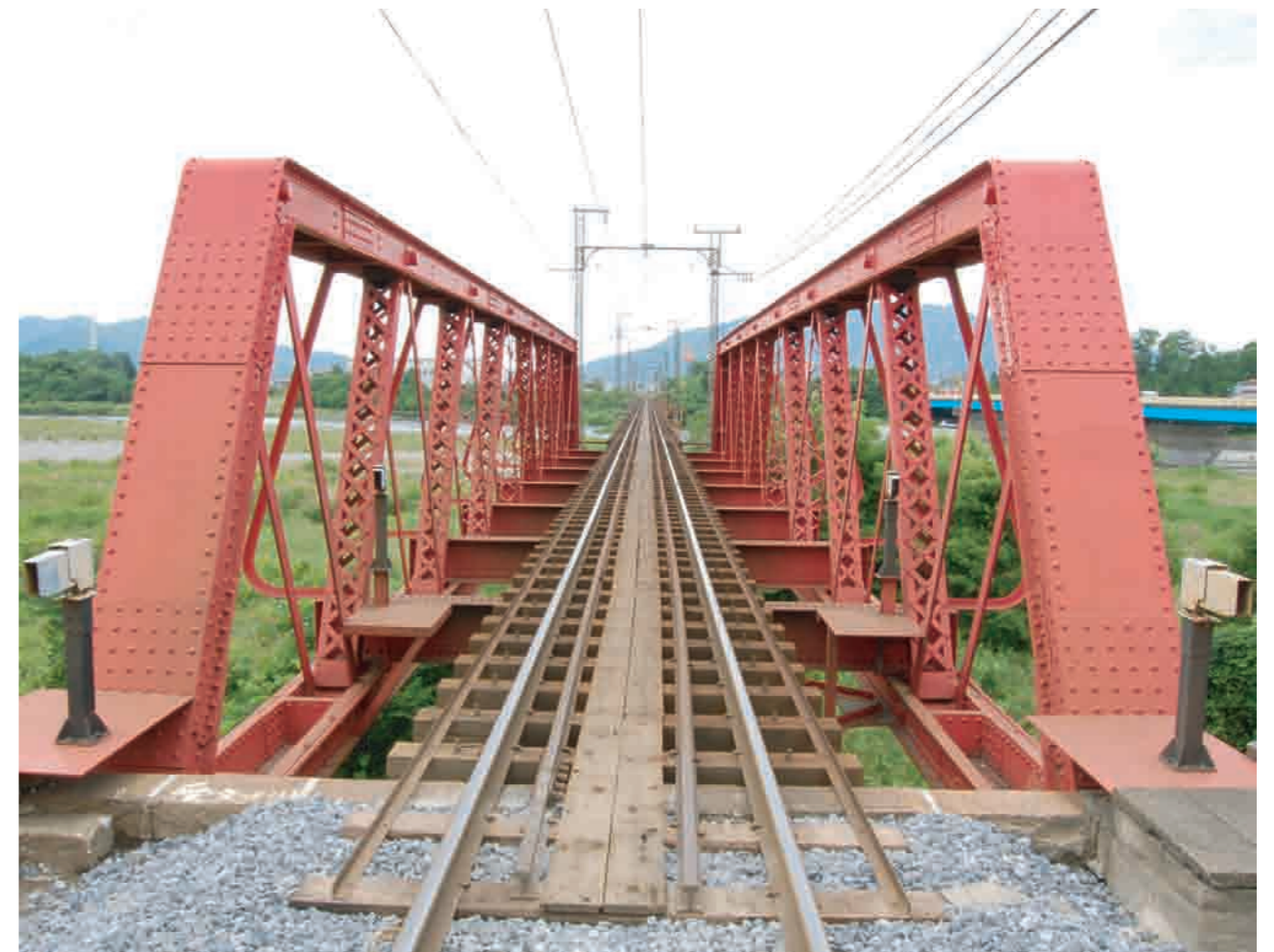
近江鉄道愛知川橋梁ポニーワークレントラス
