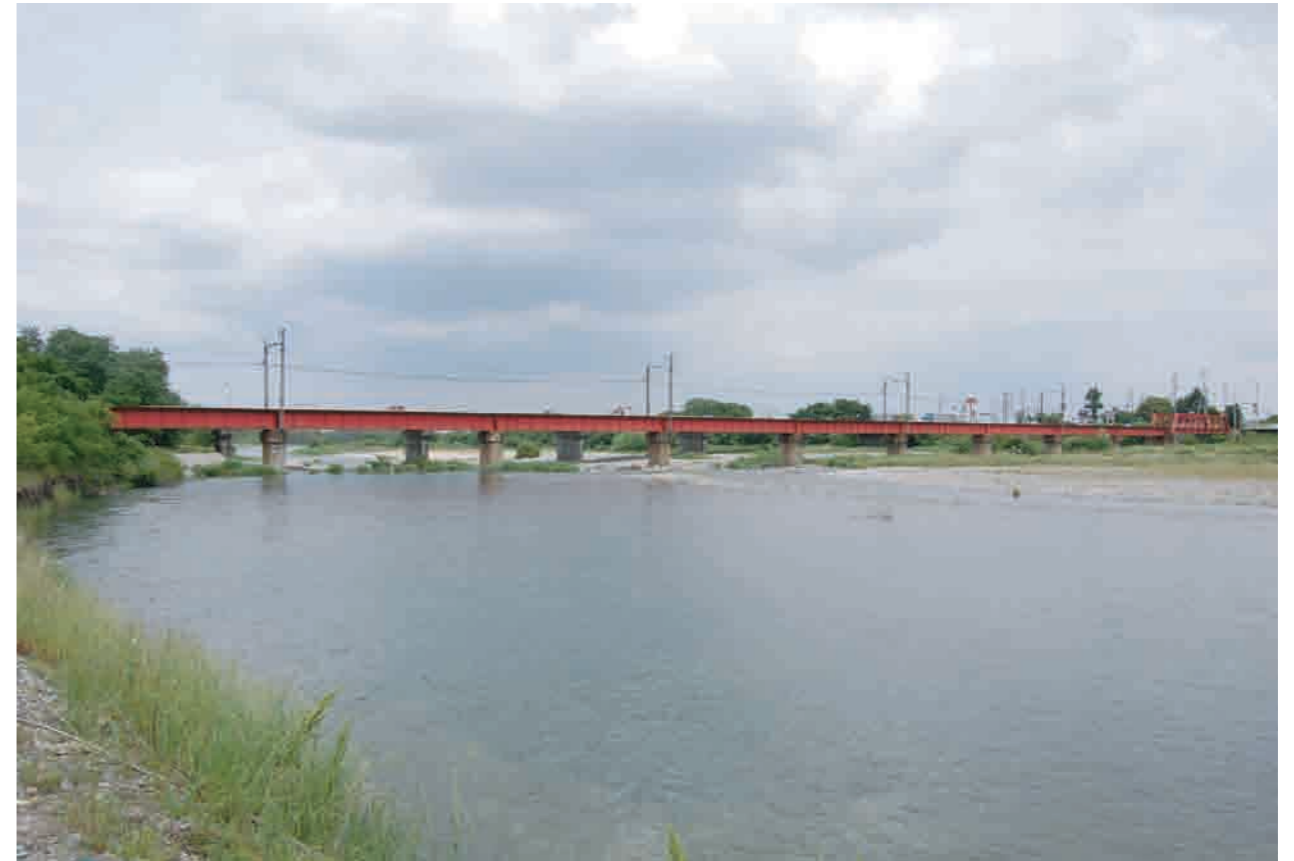
愛知川上流左岸側から見た近江鉄道愛知川橋梁
