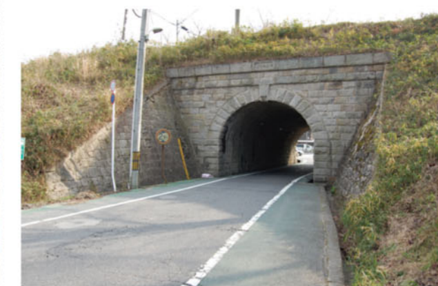
由良谷川隧道
