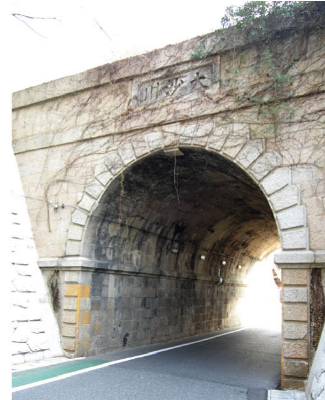
大沙川隧道西側坑門
