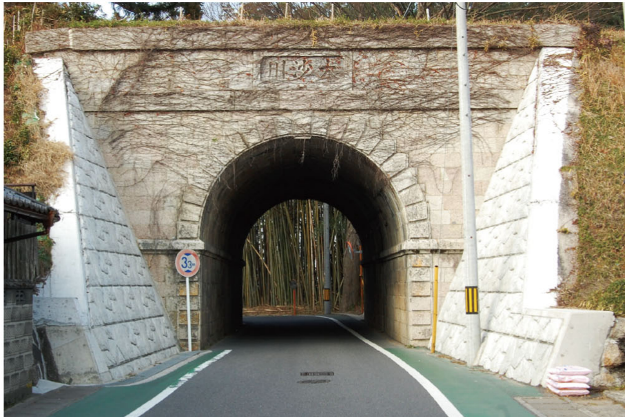
大沙川隧道東側坑門
