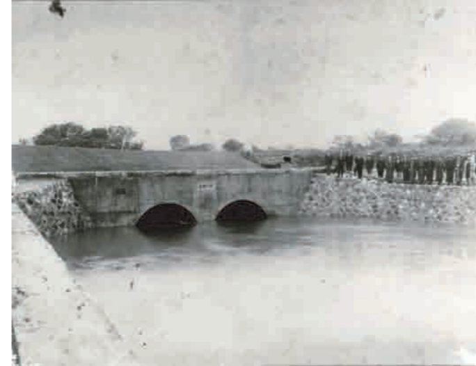
田川カルバート竣工古写真
