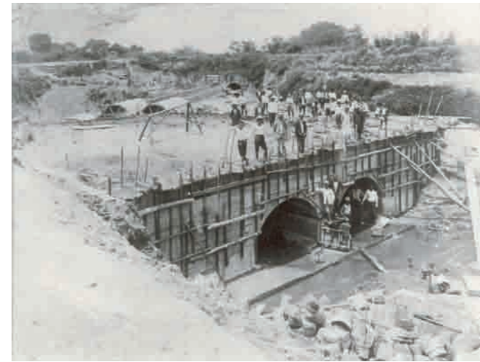
田川カルバート工事中古写真
