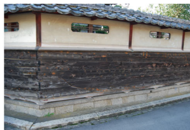
船板塀のある町並み
