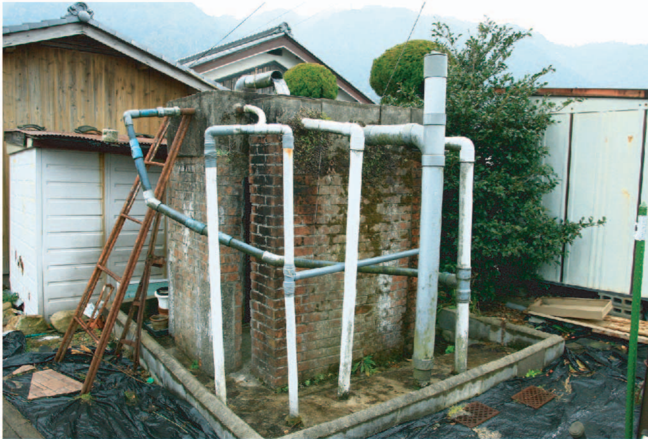
日吉山山水水道「立ち上がり」
