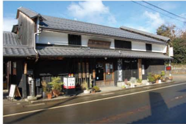
福井三四郎家住宅主屋（びれっじ2号館）
