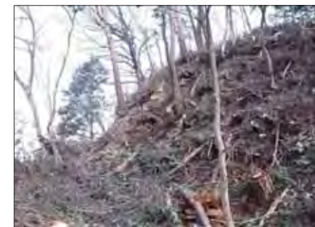
二の丸北端の大堀切 写真
