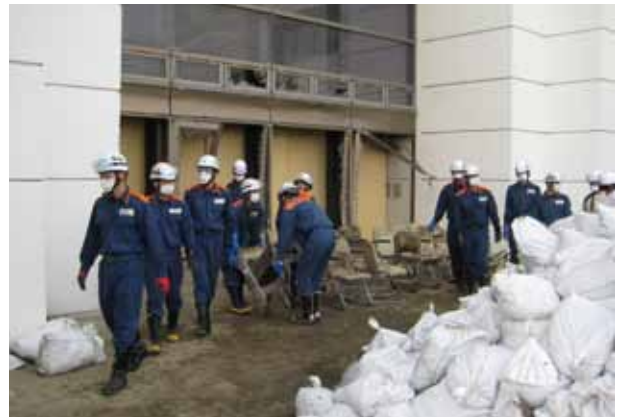
土のう袋約3000個分の泥と瓦礫を運び出す
