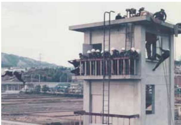
訓練塔からの懸垂降下・渡過訓練（昭和48年）
