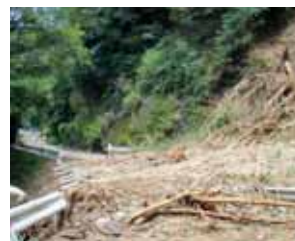
大津市南部豪雨(H24年8月)による県道大津南郷宇治線の被害状況
