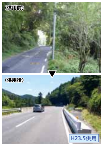
»国道422号(大石拡幅)
