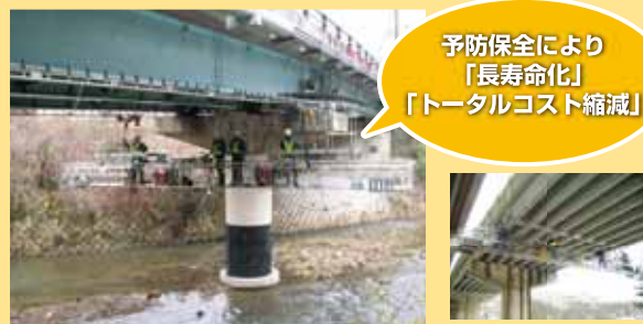
【橋梁点検の様子】
