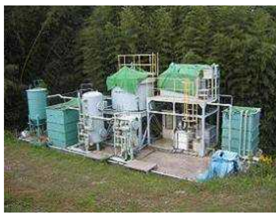
② 処理施設の設置 （平成14年11月完了）
