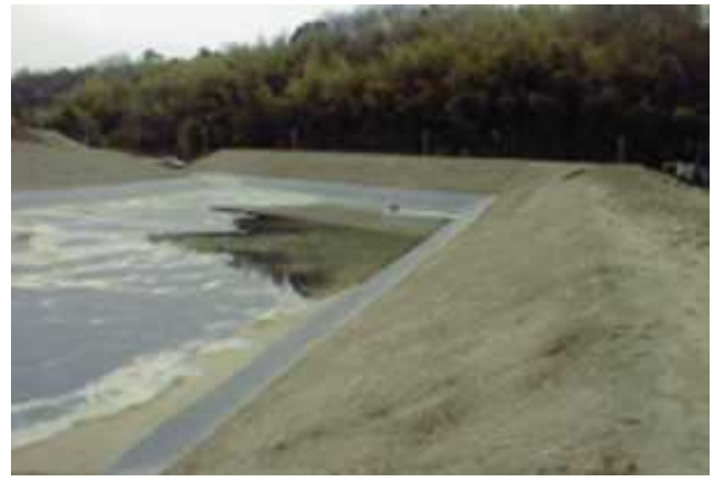
④ 沈砂池の設置 (平成 14 年 11 月完了)
