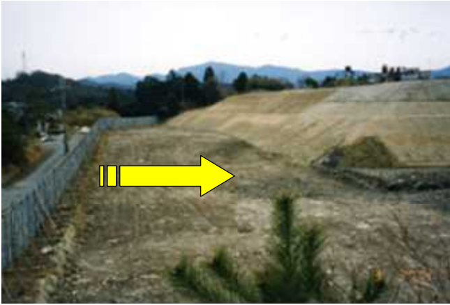
③ 北尾団地側法面後退工事 (平成 16 年 3 月完了)
