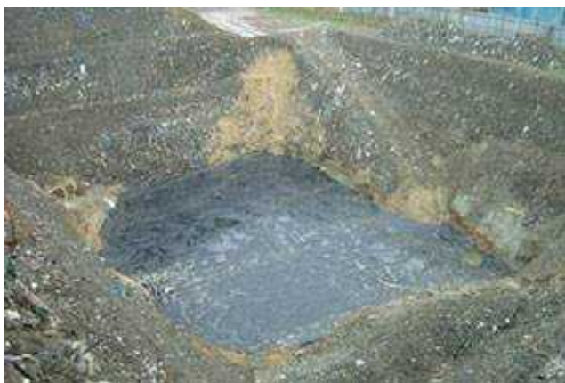
① 深掘箇所の是正（遮水シートの敷設） （平成17年6月完了）
