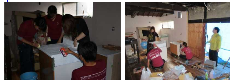
古民家改修の様子
