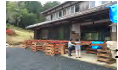
曳家による嵩上げ
