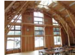
地元設計会社の協同組合が考案した「すだれ梁構法」。児童が直接目にすることができる。
