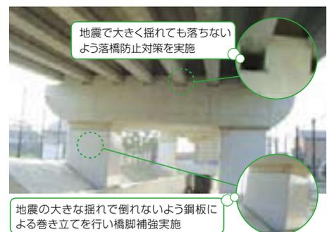
落橋防止や橋脚補強による耐震対策
