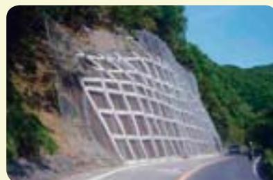
斜面の対策工事による通行車両の安全確保
