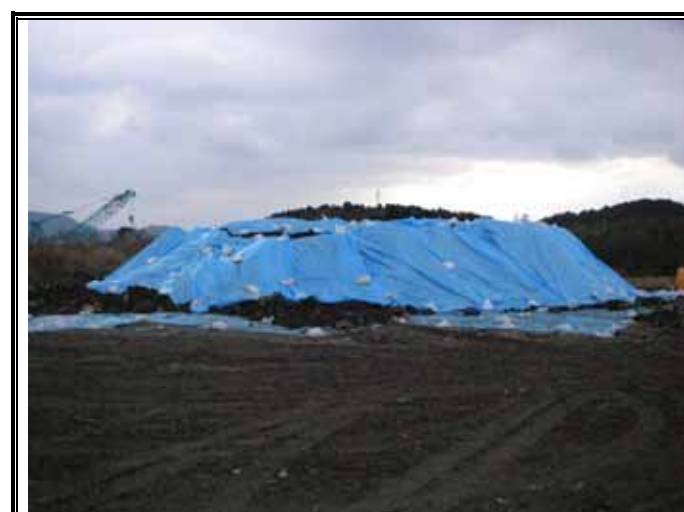
仮置きヤードのシート養生
