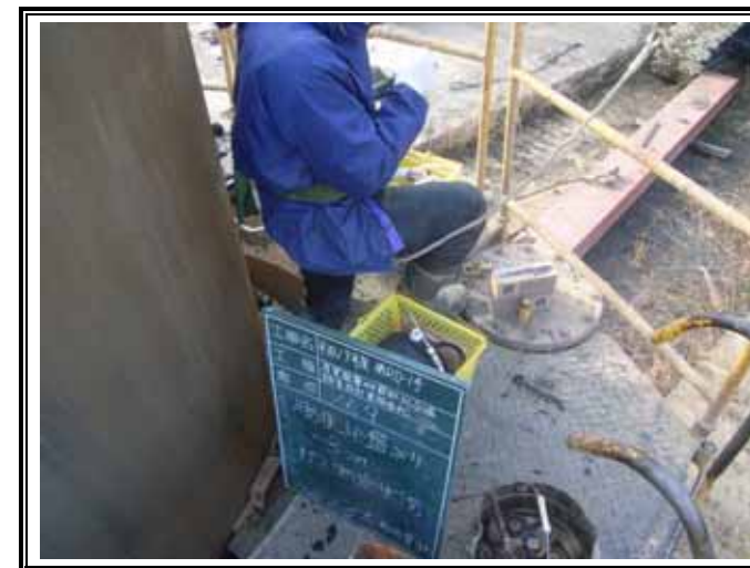
ガス測定状況(GL-3.00m)
