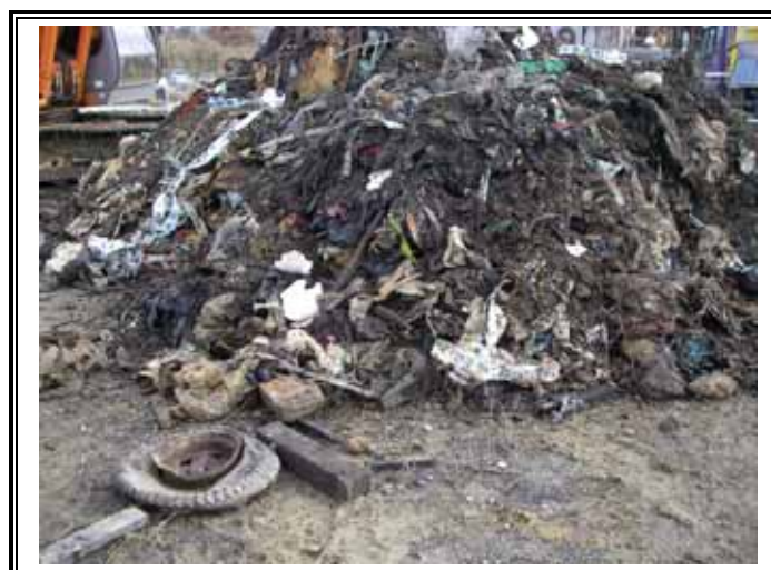
掘削した廃棄物の仮置き状況
