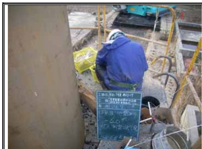
ガス測定状況(GL-6.00m)
