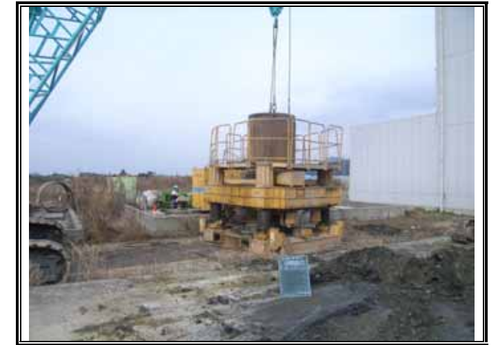
ケーシング抜管状況
