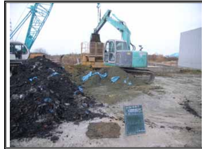
バックホウによる埋戻状況
