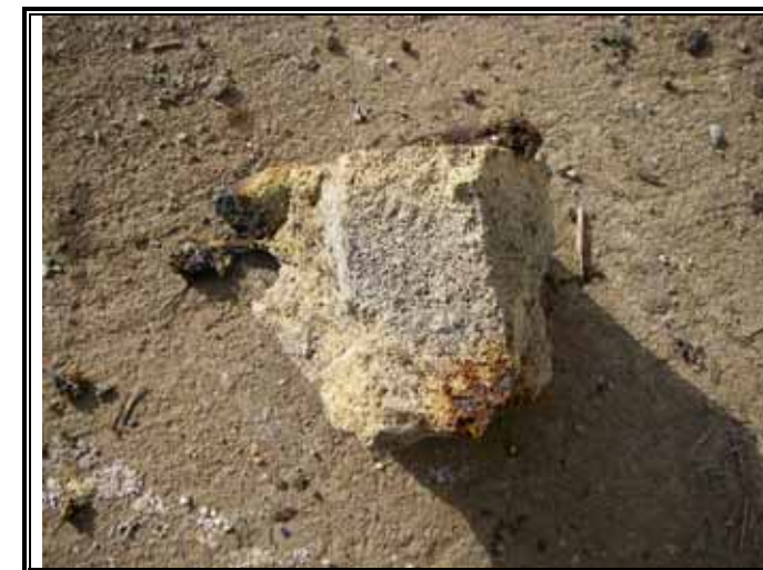
雑物除去 発泡モルタル
