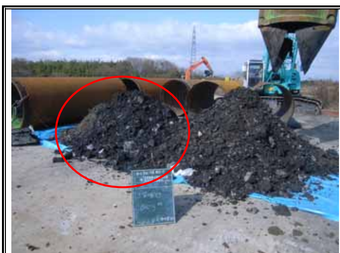
掘削廃棄物土(GL-0.00~-3.00m)
