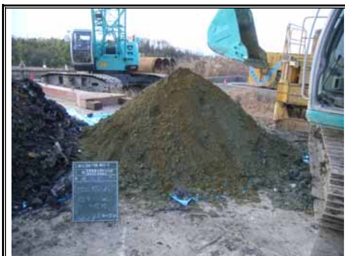
掘削土地山 (GL-12.30 ~ -15.35m)
