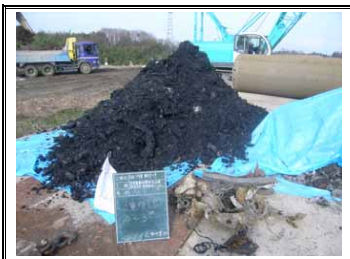
掘削廃棄物土(GL-0.00 ~ -3.00m)
