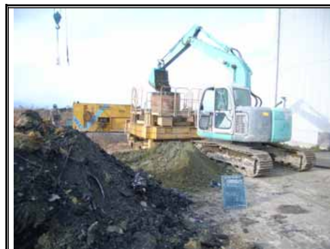
バックホウによる埋戻状況
