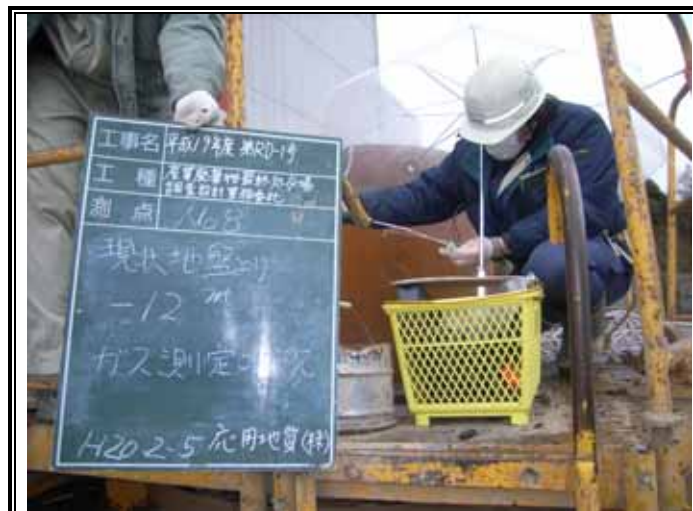
ガス測定状況 (GL-12.00m)
