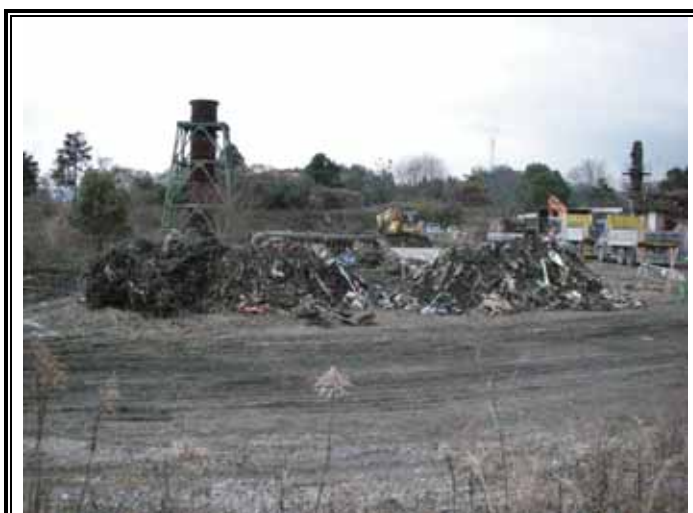
掘削残土の仮置き状況
