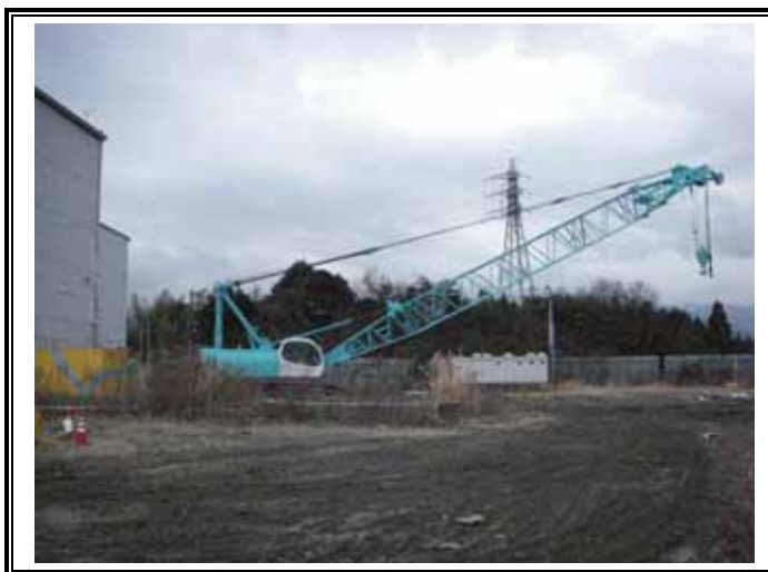
65t 吊 クレーン
