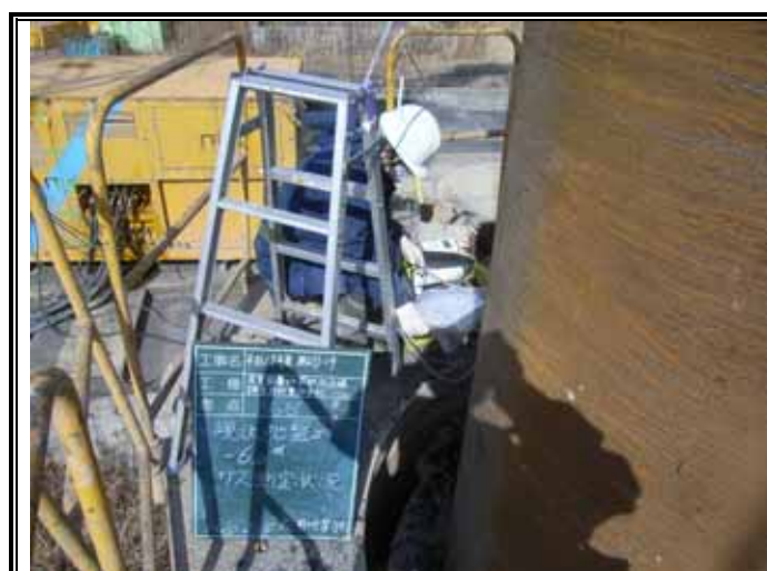
ガス測定状況(GL-6.00m)
