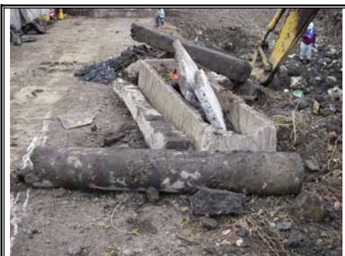
雑物除去 コンクリートがら
