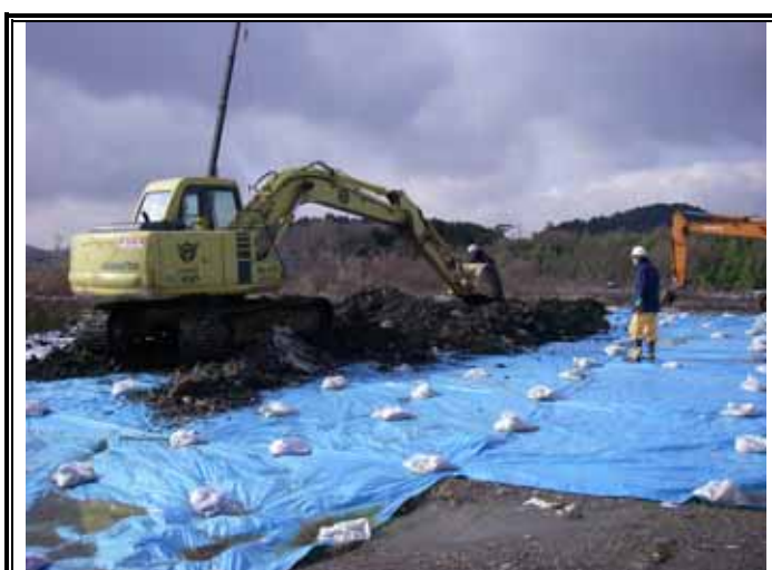
仮置きヤードの全景
