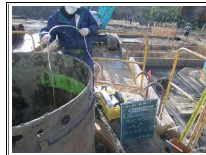
ガス測定状況 (GL-15.35m)
