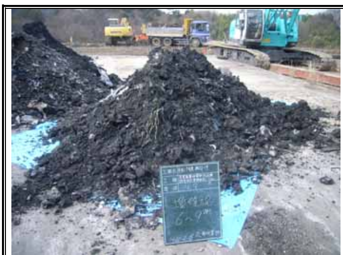
掘削廃棄物土(GL-6.00 ~ -9.00m)
