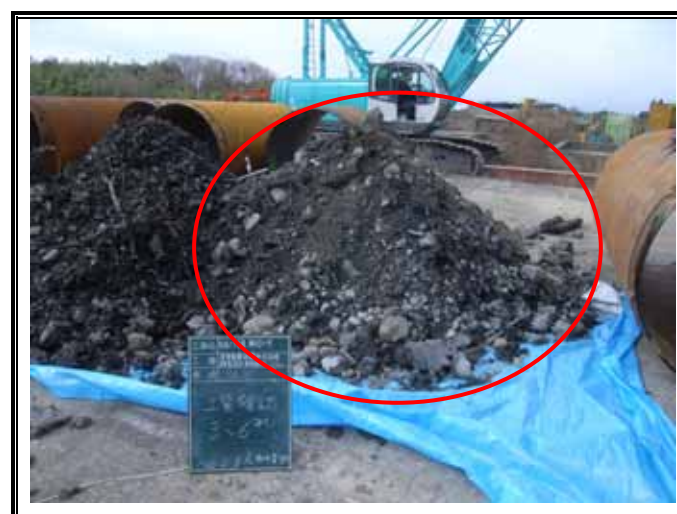
掘削廃棄物土(GL-3.00~-6.00m)
