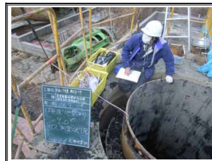
ガス測定状況(GL-9.00m)
