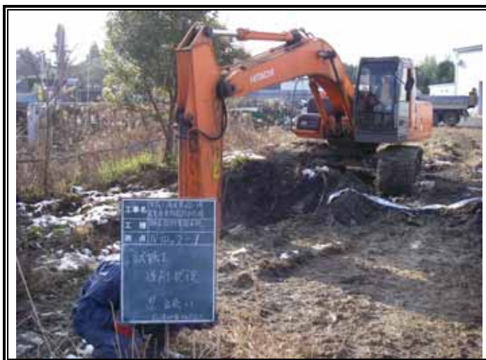
試掘(掘削状況)
