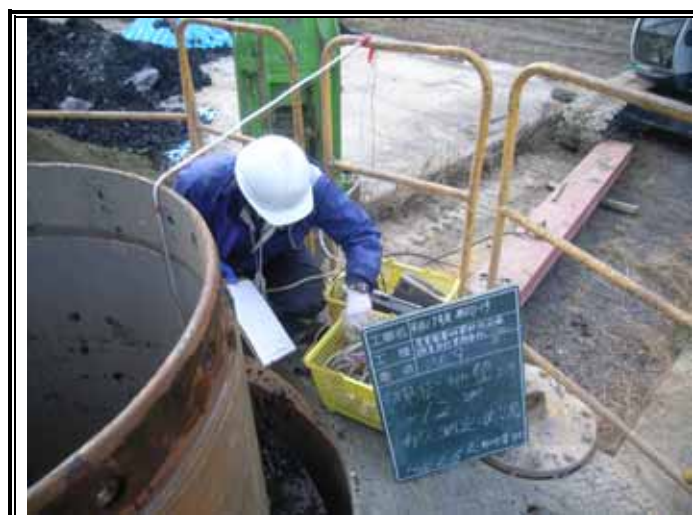
ガス測定状況(GL-12.00m)
