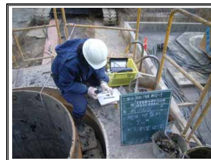
ガス測定状況(GL-9.00m)
