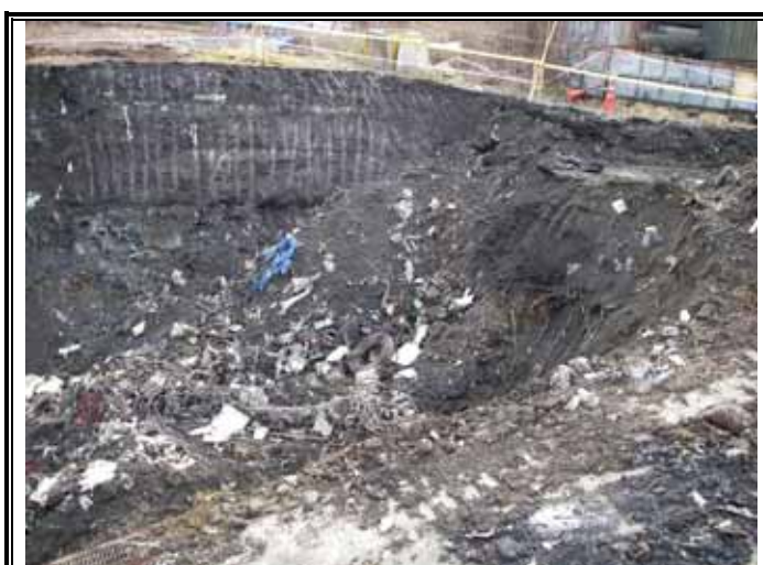
埋め立て廃棄物の状況
