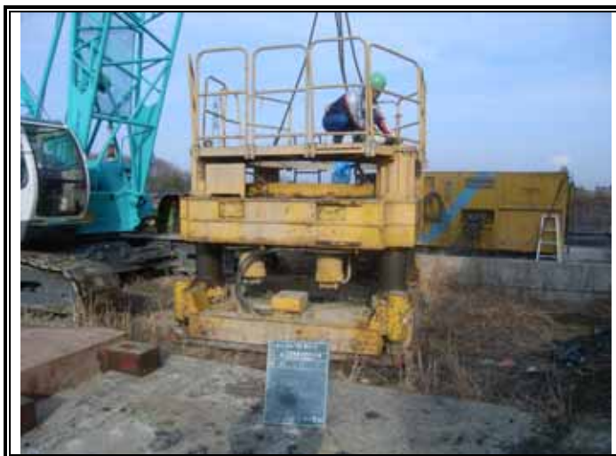
全周回転式油圧ジャッキ設置
