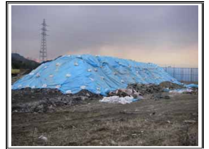
仮置シート養生の状況
