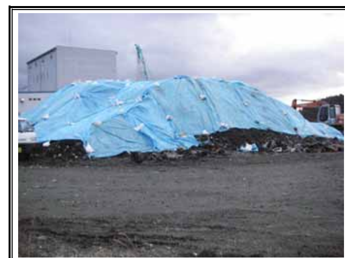
仮置きヤードのシート養生
