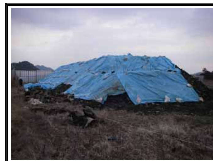
仮置きヤード シート養生の状況
