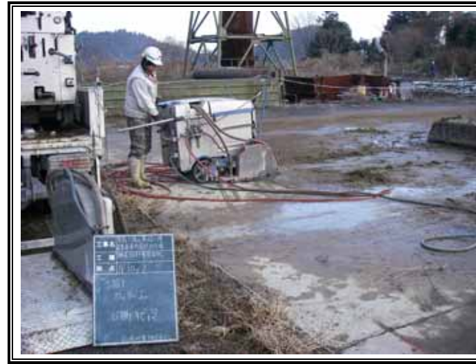
コンクリートカッター入れ
