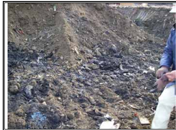
廃棄物の埋め立て状況
