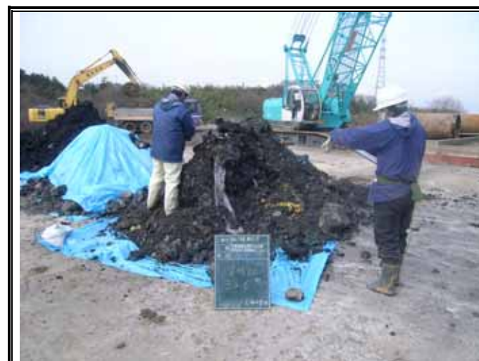
掘削廃棄物土(GL-3.00 ~ -6.00m)
