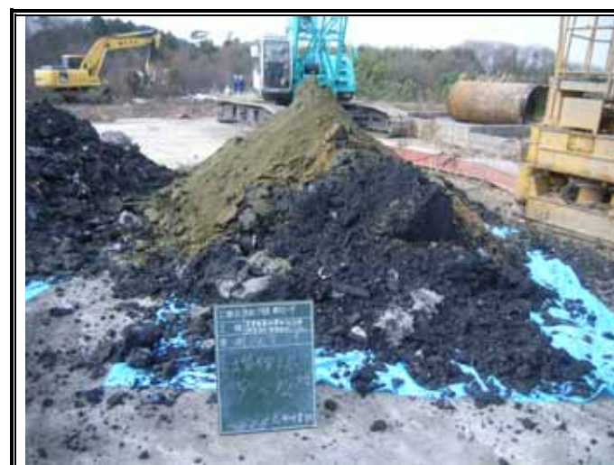
掘削廃棄物土(GL-9.00 ~ -12.00m)
