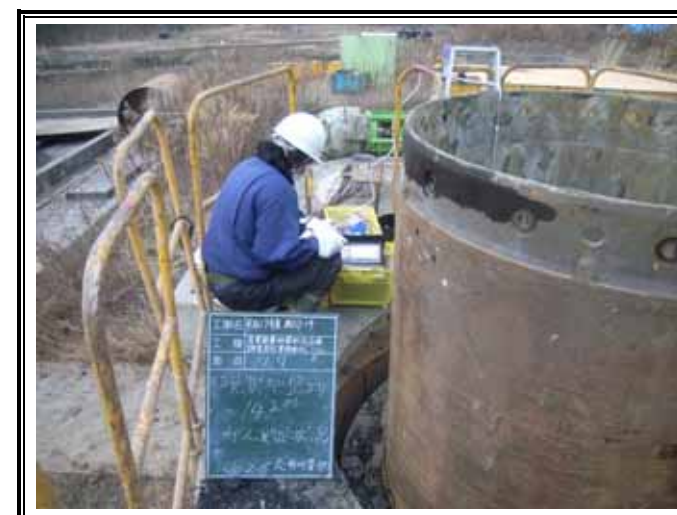
ガス測定状況(GL-14.20m)
