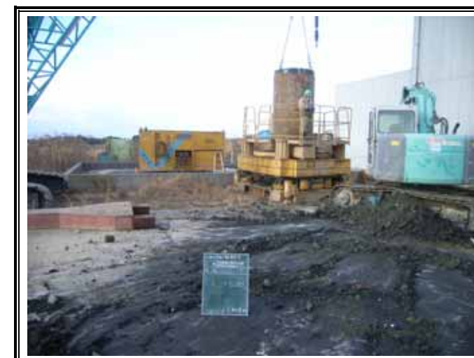
ケーシング抜管状況
