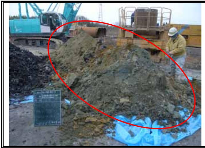
掘削土山(GL-10.80~-14.20m)
