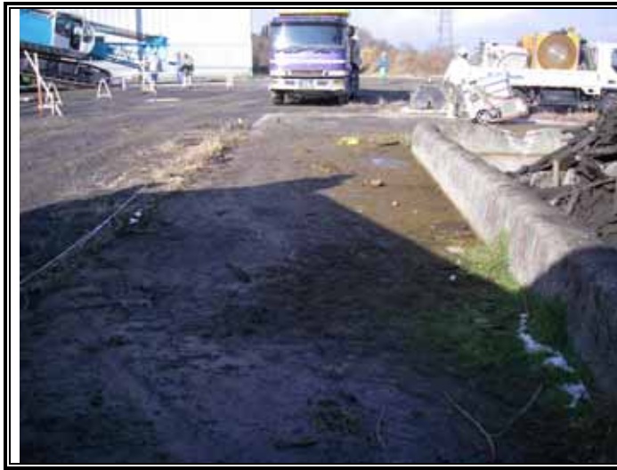
着手前の全景
