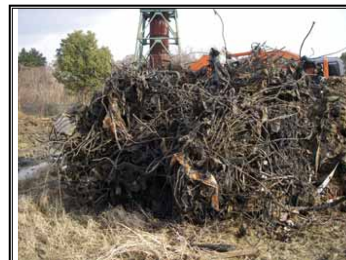
掘り出された鉄筋塊
