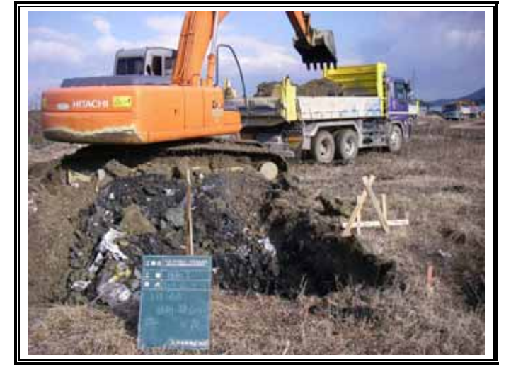
掘削・積み込み状況
