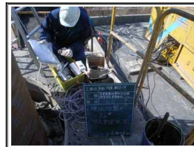
ガス測定状況(GL-3.00m)
