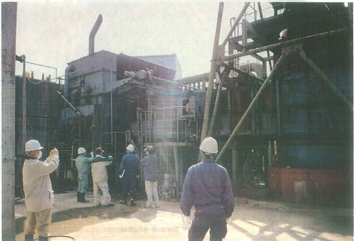
燃烧炉下部（灰出口）
