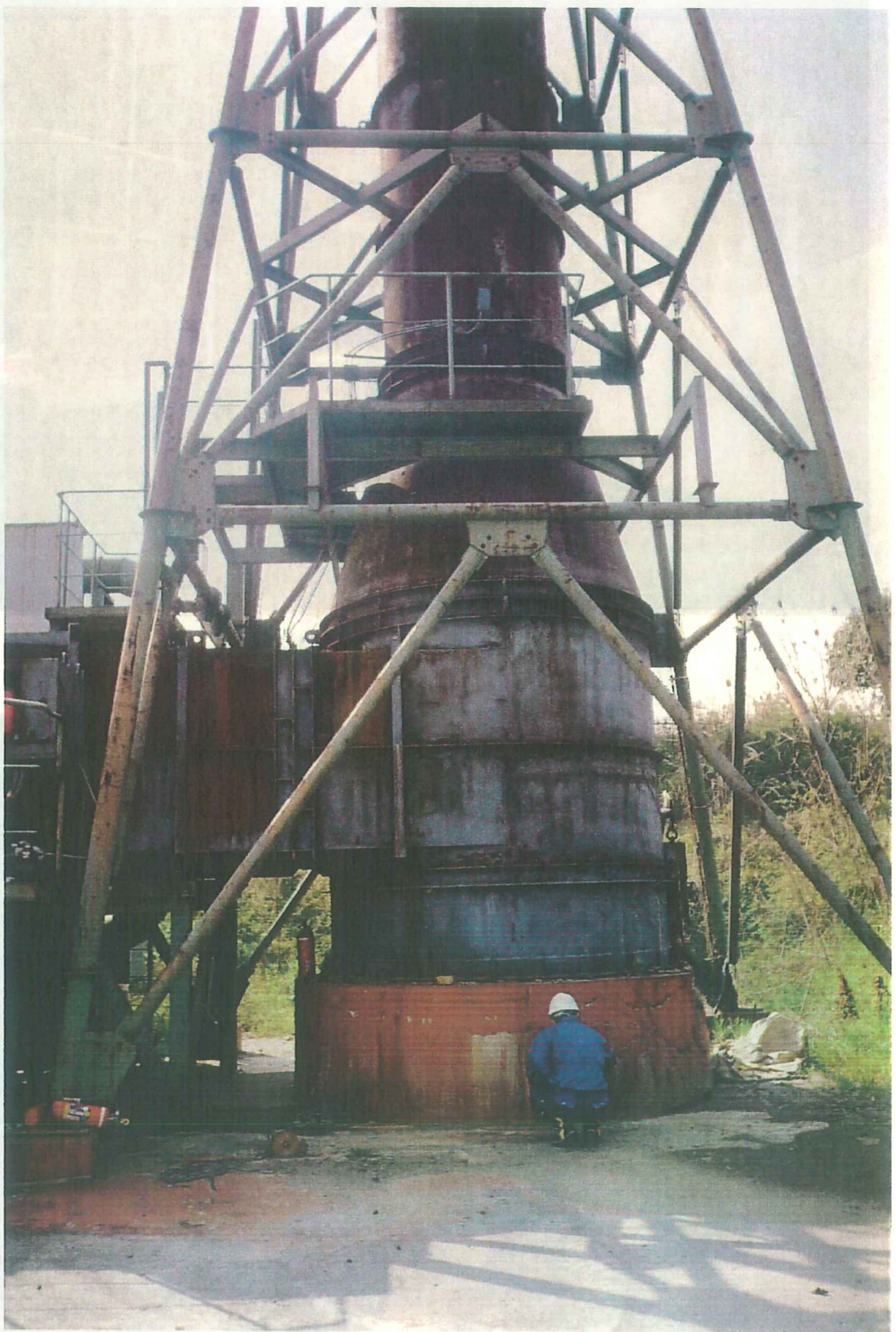
②煙突下部全景（点検口）
