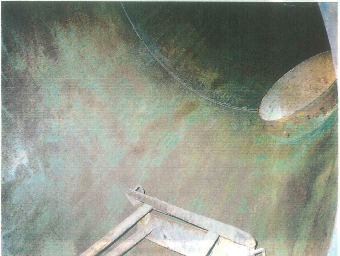
④煙突内部
