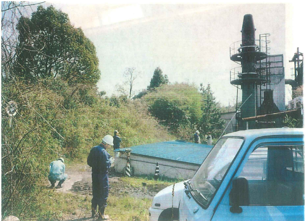
④煙突と集塵機を望む
