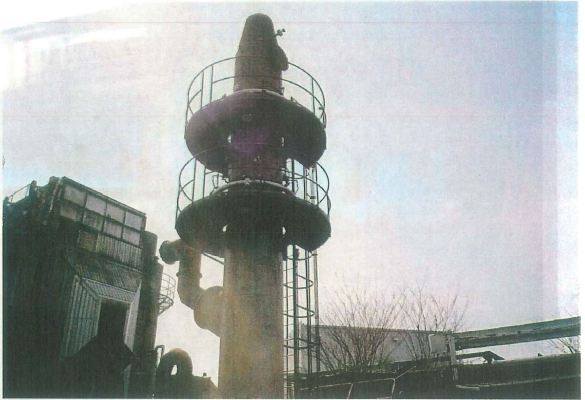
④煙突と集塵機を望む
