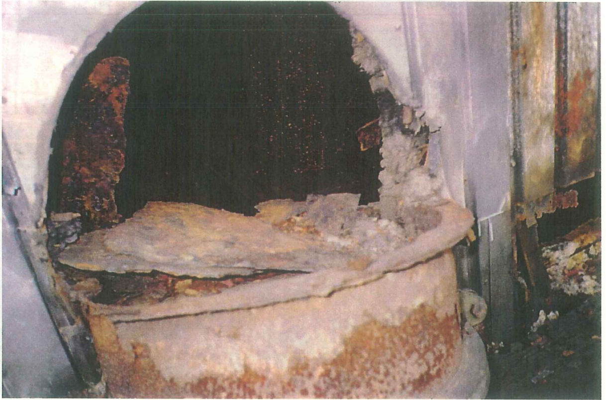
(口)出部 ③集塵機上部
