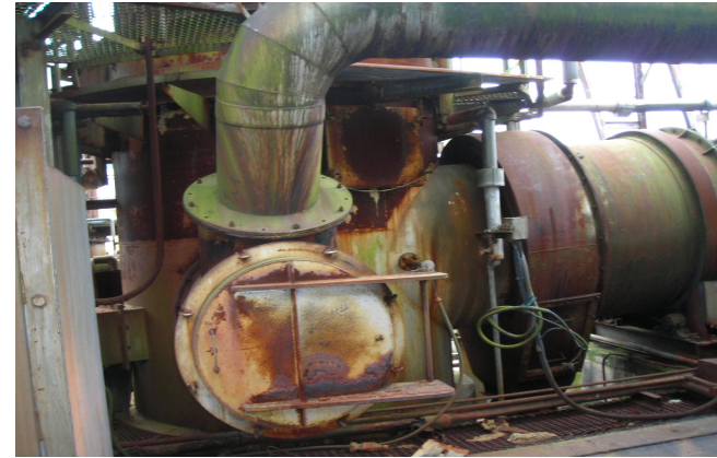
①冷却塔下部（点検口）
