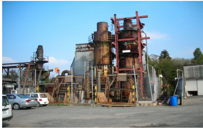
南側焼却炉全景
