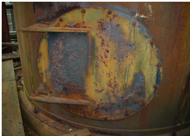
②冷却塔点検口（拡大部）
