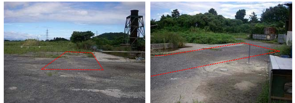
○IVブロック (処分場上面：パックホ-による掘削：1箇所)
