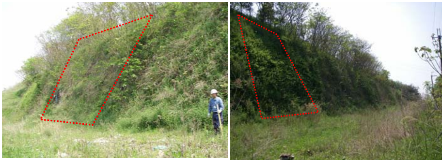
○Iブロック (西市道側法面：パックホ-による掘削：2箇所)
