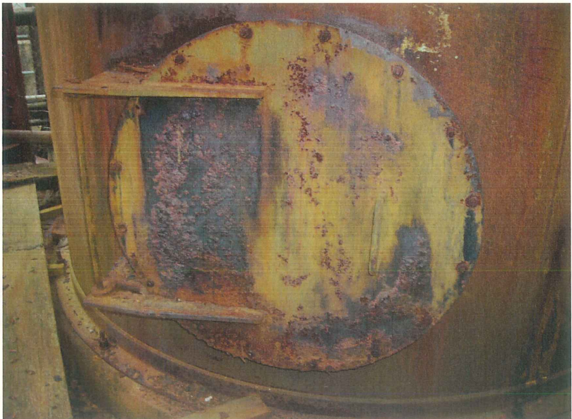
② 冷却塔点検口（拡大部）
