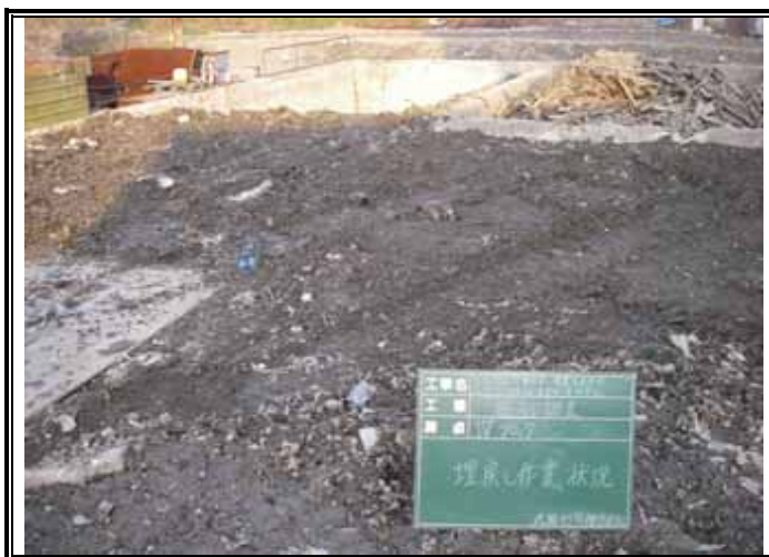
-3 埋め戻し状況
