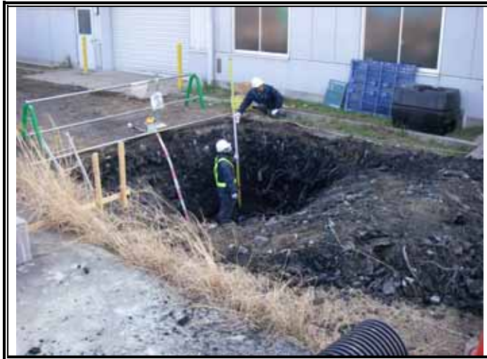
-1(西) 掘削坑の全景
