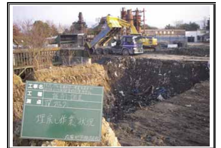
埋め戻し作業状況
