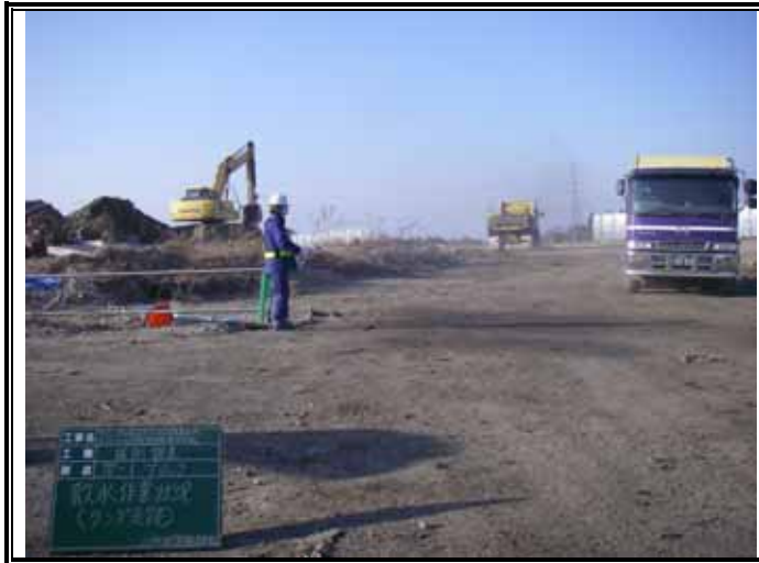
ダンプ走路散水作業状況
