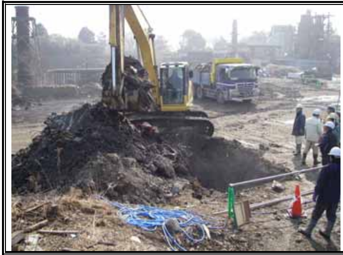
ケーシング 周辺掘削状況
