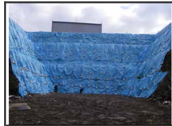
掘削終了後の法面養生
