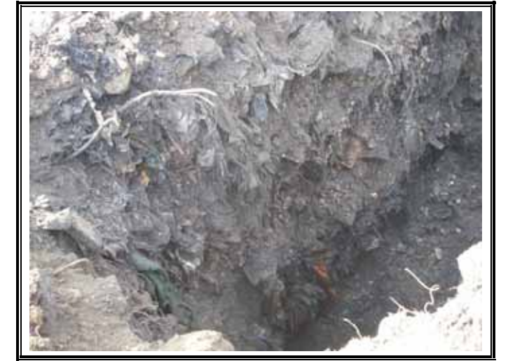
掘削孔の状況
