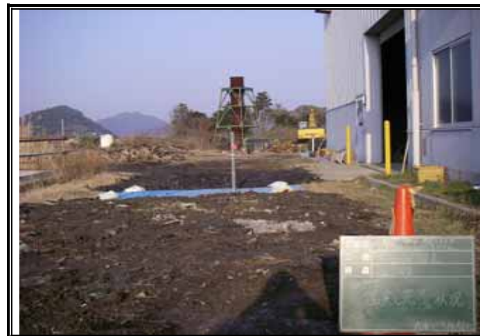
ブロック 埋め戻し完了状況 全景
