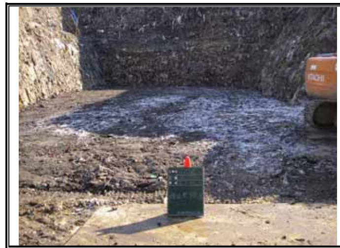
床掘り 埋め立て完了状況
