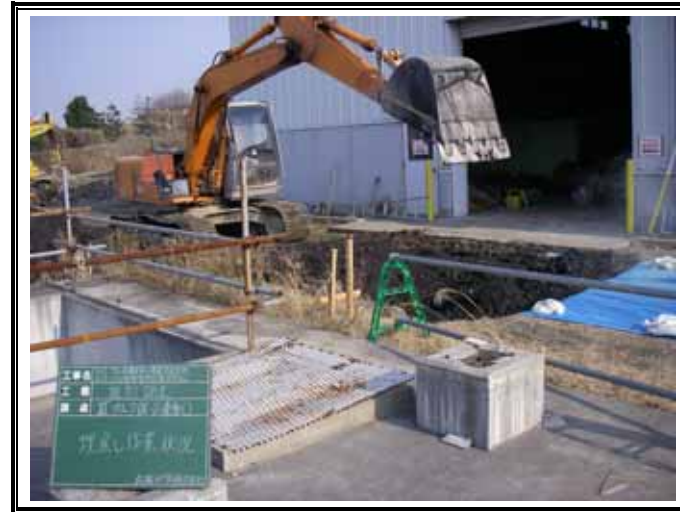
-2(東) 掘削坑の全景
