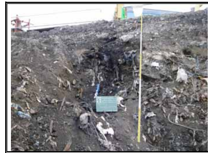
-3 オイルエレメントの埋め立て状況
