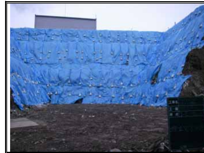
掘削終了後の法面養生
