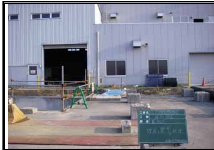
-1(西) 埋め戻し完了状況
