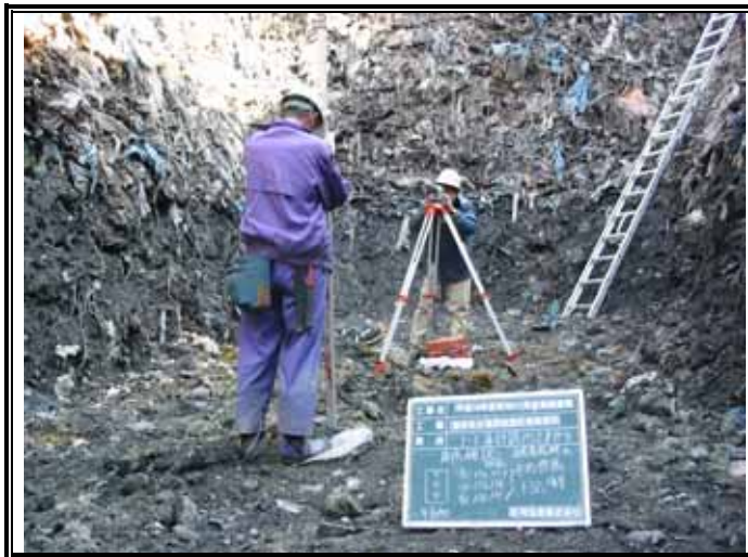
床掘 掘削状況
