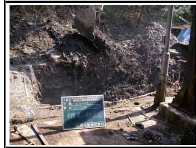
E-2ブロック 埋め戻し状況
