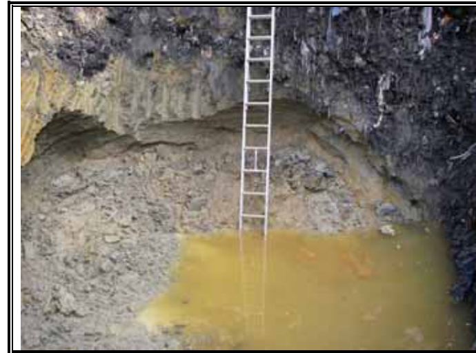
床掘 掘削状況(2)
