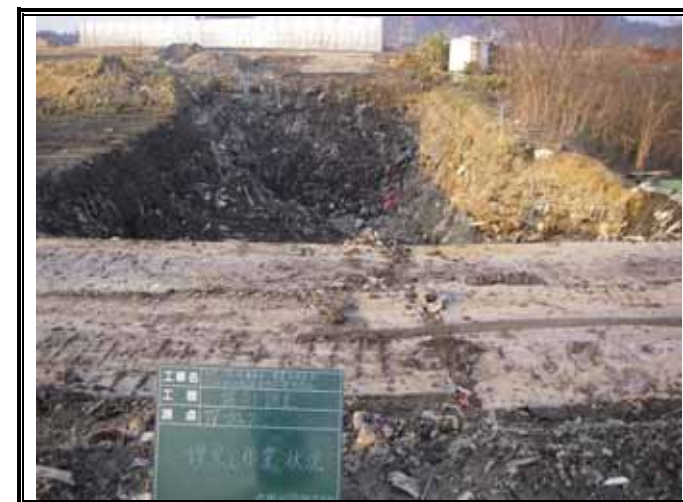
-4 埋め戻し状況
