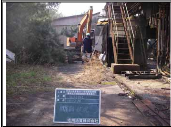
E-2ブロック 掘削状況(1)
