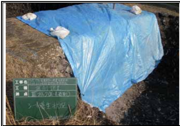
-1(西) シートによる仮養生の状況
