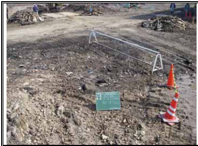
埋め戻し完了状況
