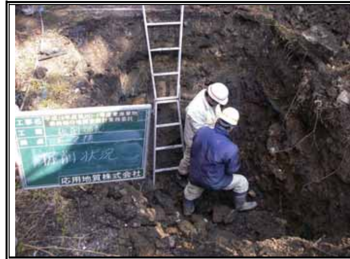
E-2ブロック 掘削状況(2)
