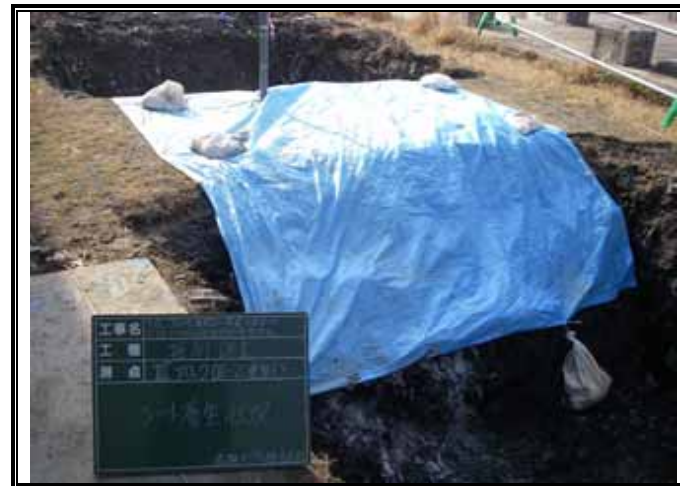
-2(東) シートによる仮養生の状況
