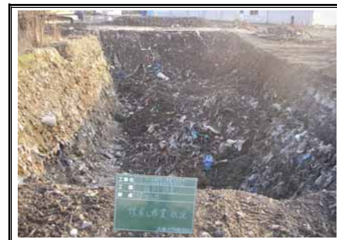
埋め戻し作業状況
