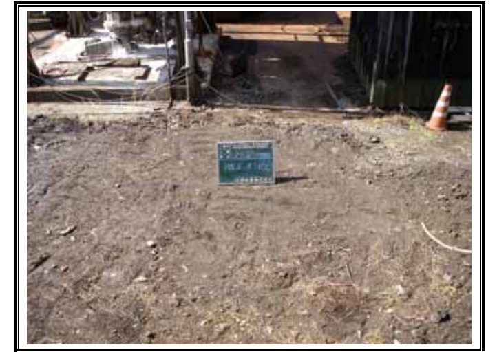
E-2ブロック 埋め戻し状況
