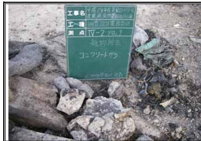
雑物除去 コンクリートガラ
