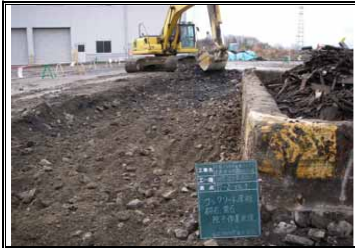
床板碎石除去作業状況
