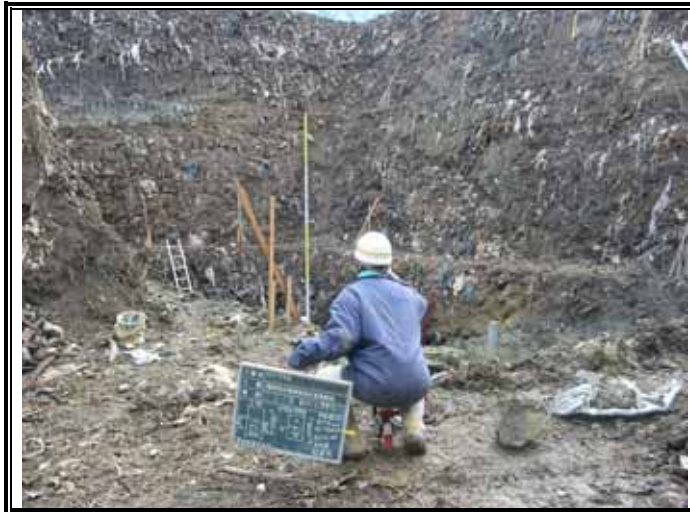
床掘 掘削状況(1)
