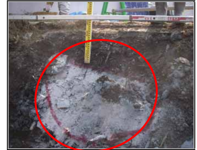
写真 3.4 -1(東) 切削クズの埋立て状況
