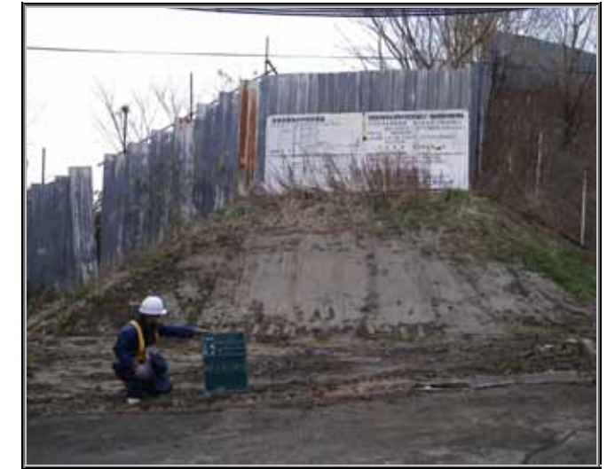
写真5.4 埋立完了・復旧状況
