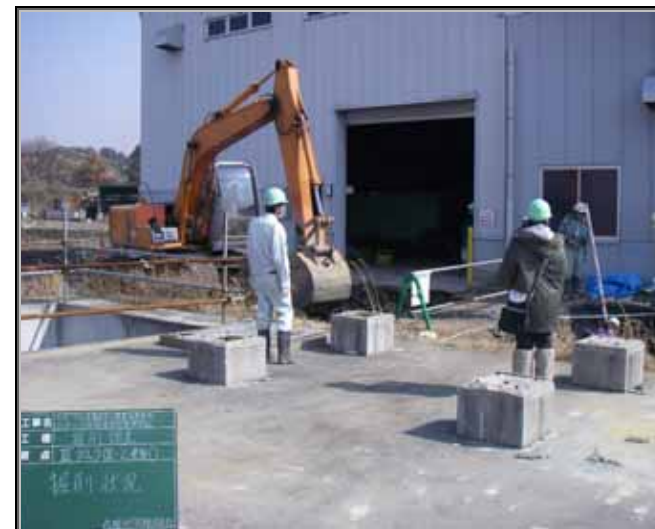
写真 3.2 -2(東) 掘削状況全景
