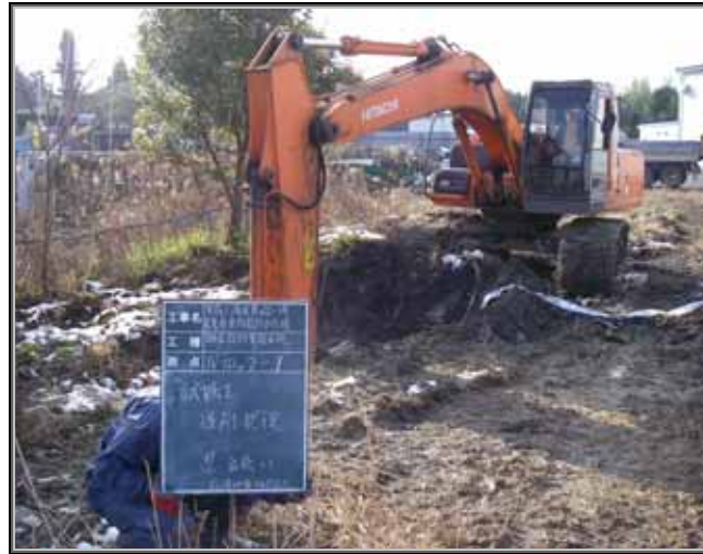
写真 4.6 -1 試掘(掘削状況)
