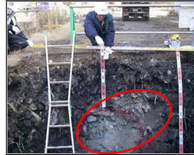
写真 3.3 -1(西) 切削クズの埋立て状況
