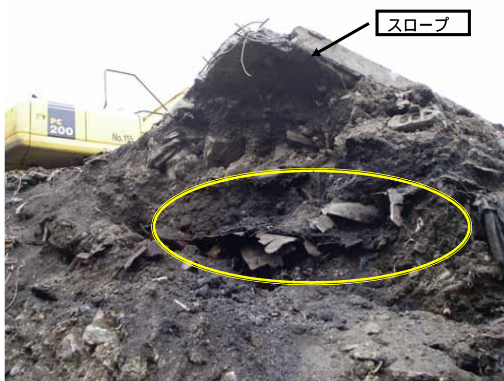
平成 20 年 2 月 15 日掘削： -4 ~ スロープ下部 1.0~1.5m
