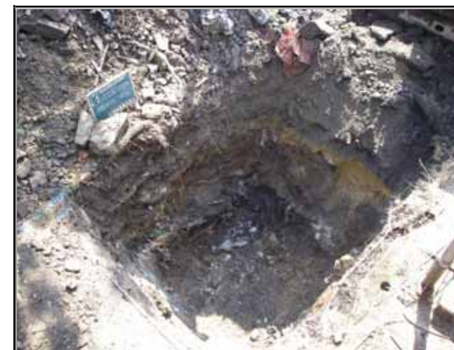
写真4.5 E-2ブロックの掘削完了後
