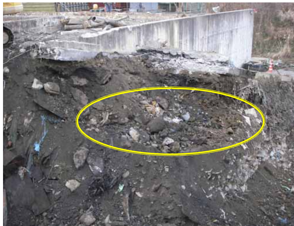
平成 20 年 2 月 15・16 日掘削： -4 ~ 58 スロープ下部 1.0~2.5m
