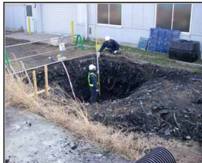
写真 3.1 -1(西) 掘削状況全景
