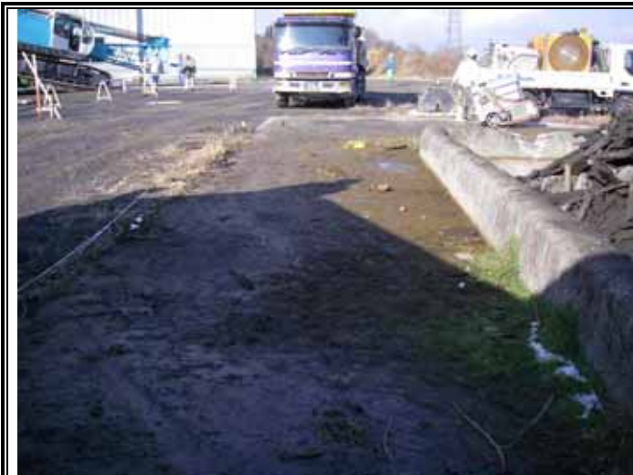
着手前の全景
