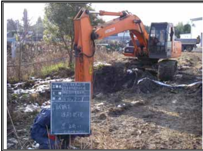
試掘(掘削状況)
