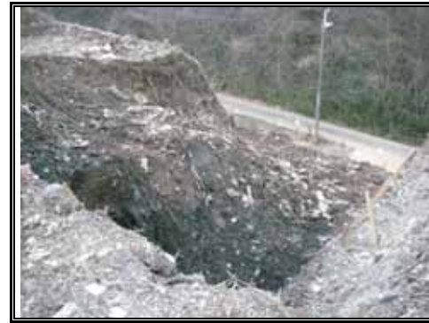
上段 掘削状況
