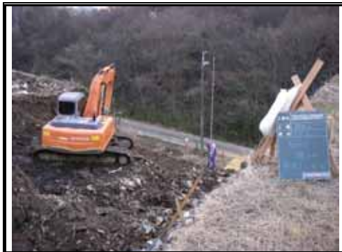
中段 掘削状況
