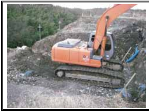
上段 掘削状況
