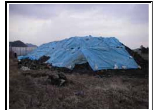
仮置きヤード シート養生の状況
