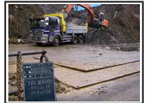
下段 掘削状況
