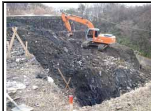
中段 掘削状況
