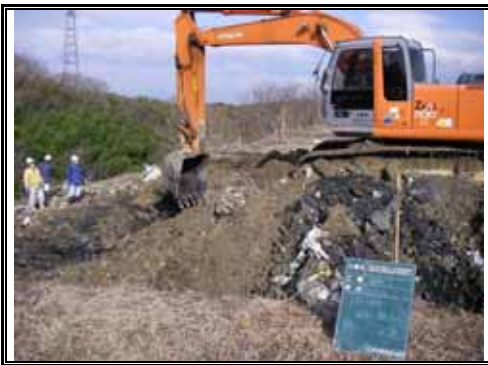
上段 掘削状況
