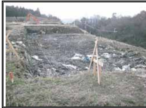
全 景 (北側より望む)
