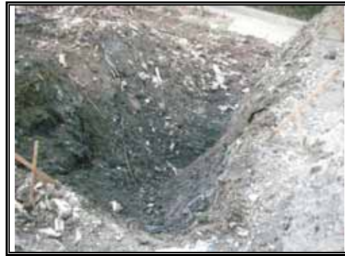
上段 掘削状況
