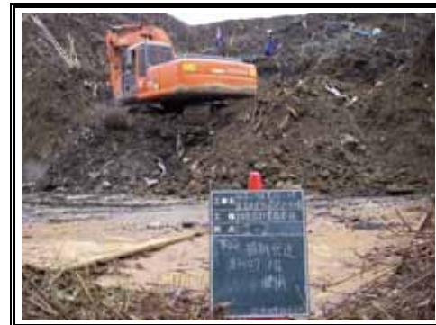
下段 掘削状況
