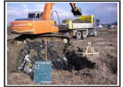
上段 掘削・積み込み状況
