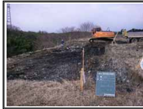
上段 掘削状況
