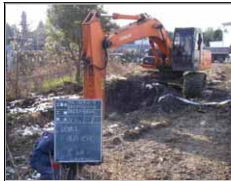
写真3.1 試掘(掘削状況)
