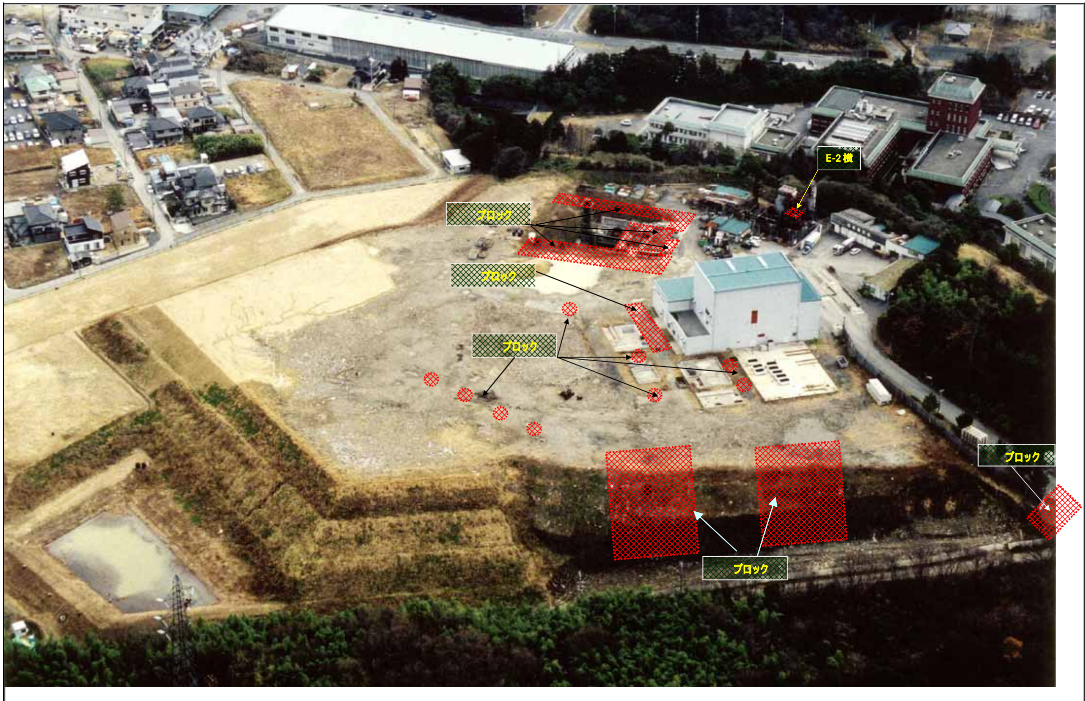
写真1 掘削調査箇所位置
