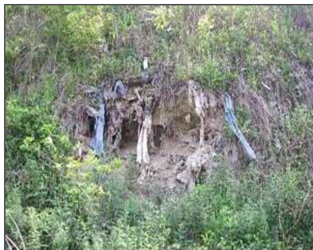
写真 2.2 法面に露出する廃棄物
