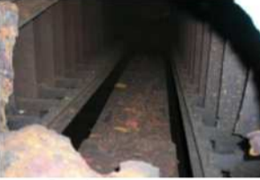
③集塵機上部（内部）
