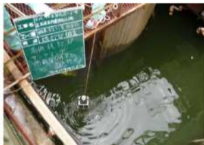
⑦焼却炉乾留炉水没部 採泥状況
