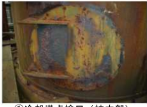
①冷却塔点検口（拡大部）
