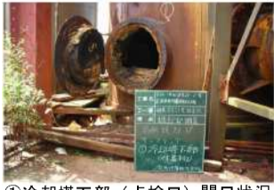
①冷却塔下部（点検口）開口状況
