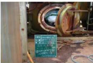
⑧燃焼炉下部 付着物採取状況
