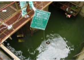
⑥焼却炉乾留炉水没部 雨水採水状況
