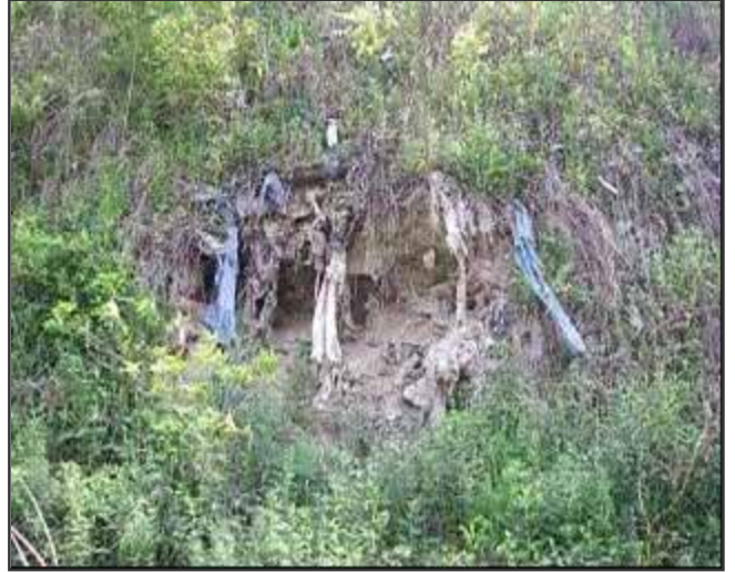
写真 2.2 法面に露出する廃棄物
