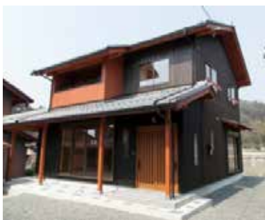
びわ湖材を使用した住宅
