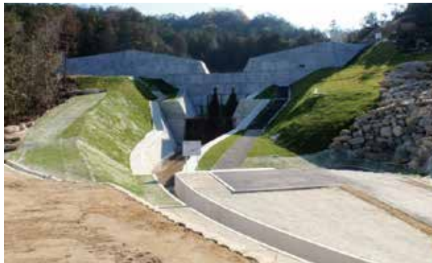
大山川支流えん堤(野洲市南櫻)
