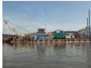
底質改善対策（高濃度薄層浚渫）
