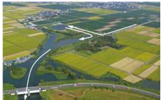
河川直接浄化事業の例（植生浄化）
