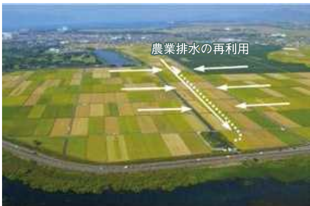
循環かんがい施設の例（木浜地区）
