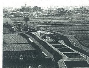
山寺川市街地排水浄化施設「伯母川ビオ・パーク」
