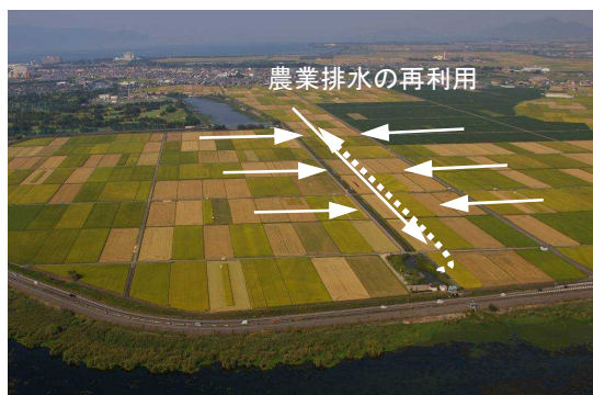
循環かんがい施設の例(木浜地区)
